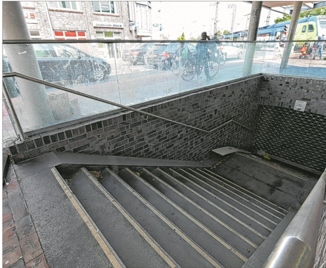
Der Tunnel an der Bremer Straße wird ab Mittwoch saniert.
